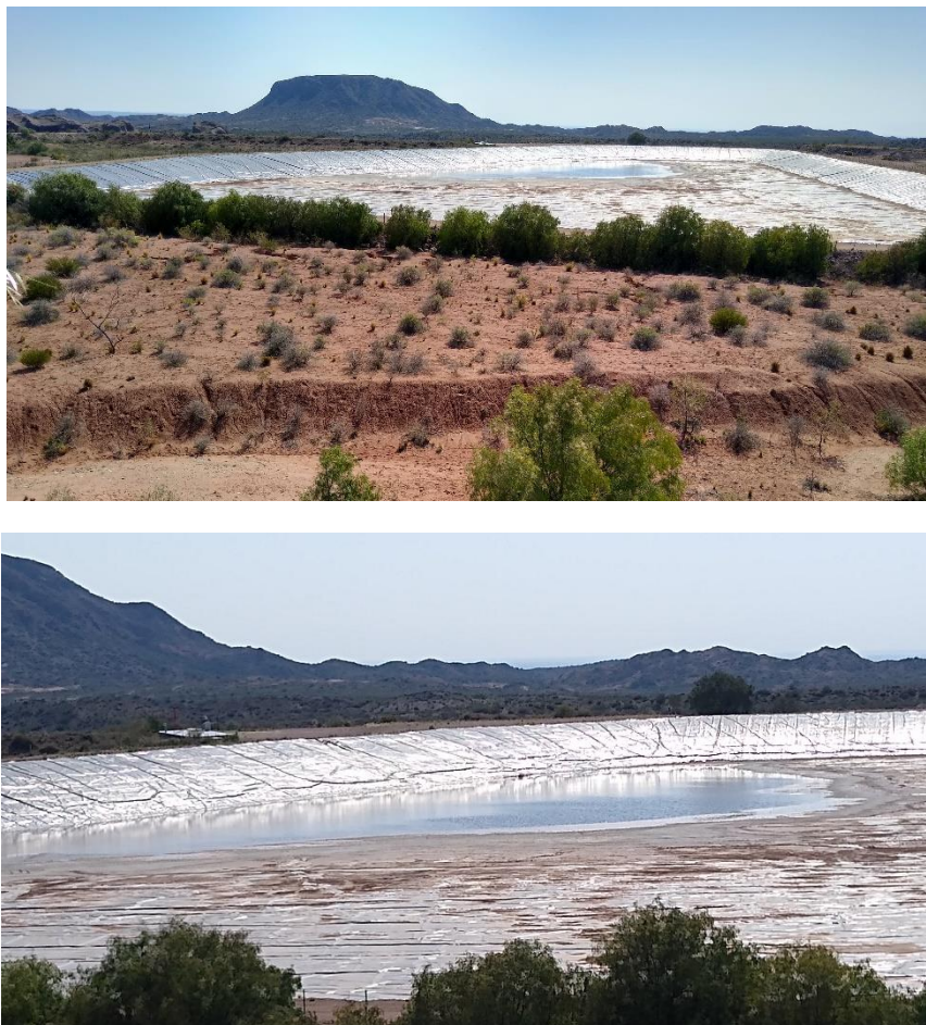
Fig.2 – Estado del Dique DN 8-9 al 16-10-20
