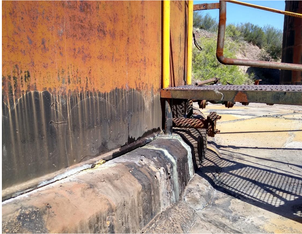
Fig.6 – Pérdida de Ácido Sulfúrico en la base del Tanque II
