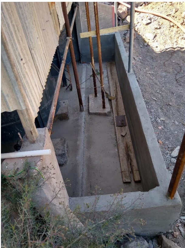
Fig.3 – Mejora realizada en la Pileta de Contención de la Planta de Neutralización.
