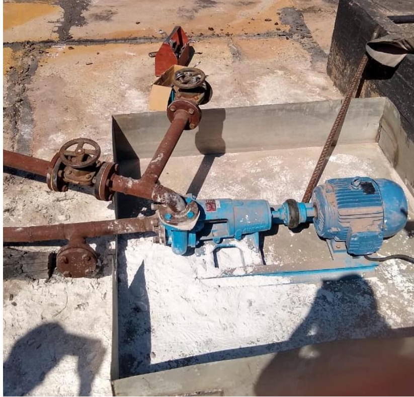
Fig. 8 – Instalación de la nueva bomba.
