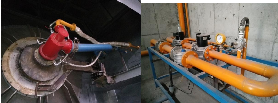
Figura 3.4 – Imagen Ilustrativa sistema de bombeo de aceite industrial para quemador horno rotatorio.
