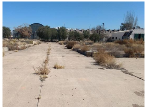
Vista Este- Oeste del predio, aquí pueden verse las empresas emplazadas en margen Norte y Oeste del
