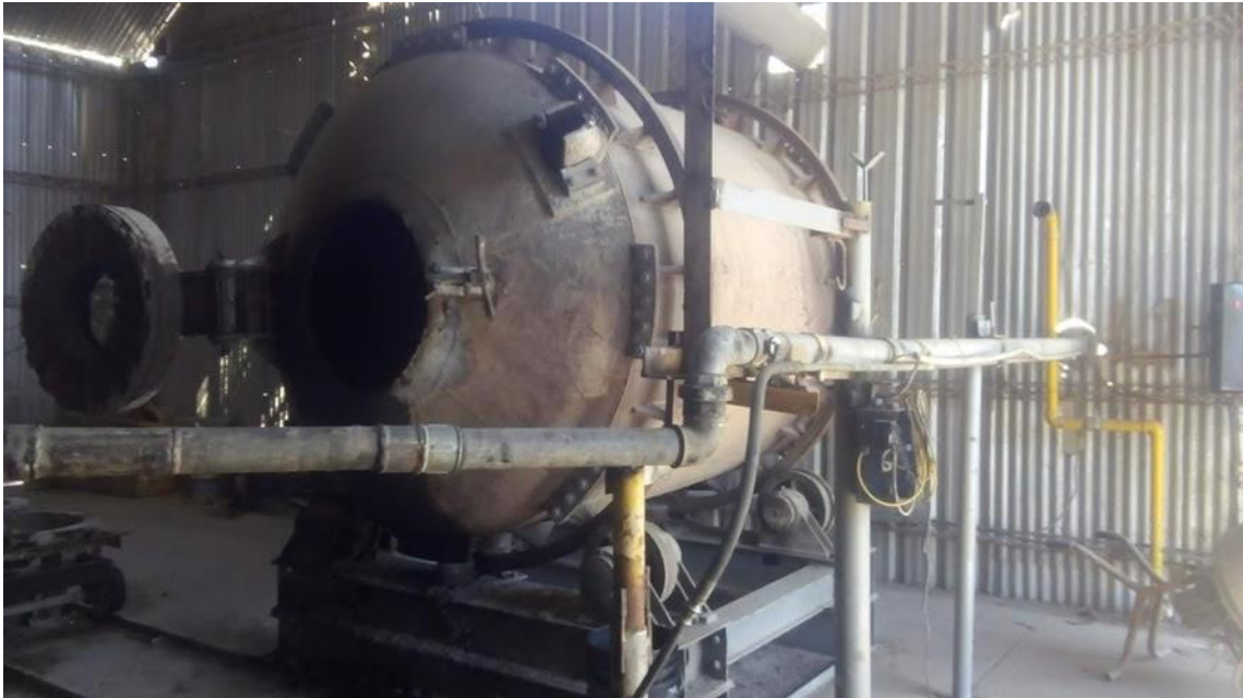
Figura 3.3 – Horno Rotatorio. Planta de Reciclado de Baterías. Parque Industria Chimbas. Pcia. de San Juan. Fuente: Imagen propia
