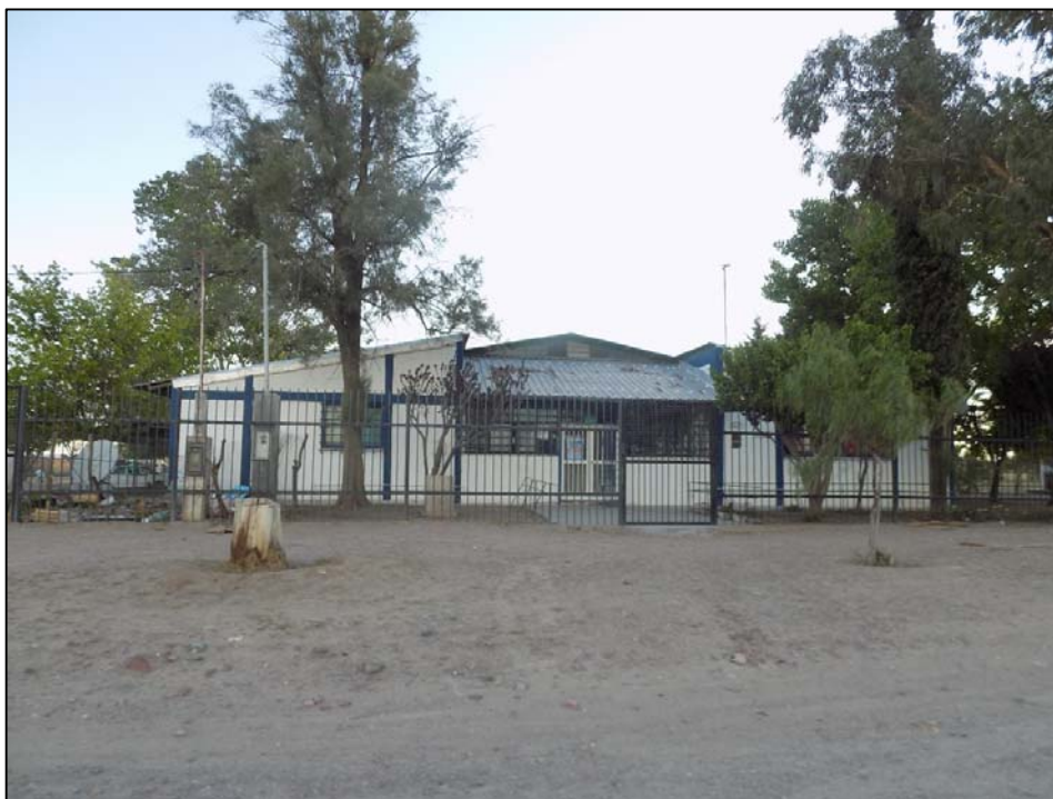
Fotografía N° 3 Infraestructura educativa en el área
