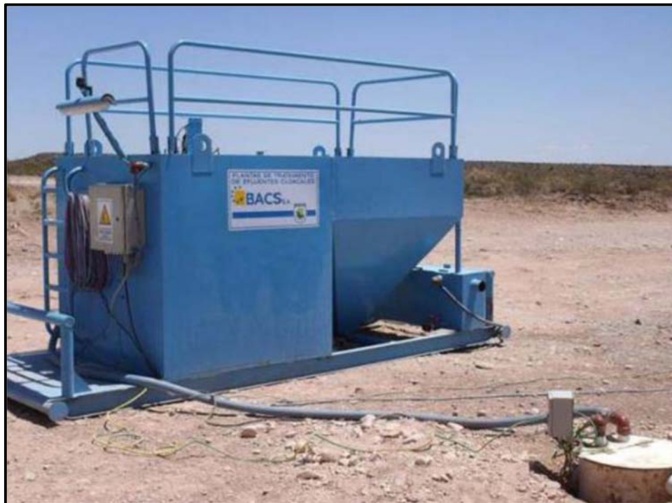
Ilustración 4-2. Planta de Tratamiento de Efluentes Cloacales
