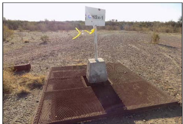
Boca de Pozo y bodega abierta con protección
