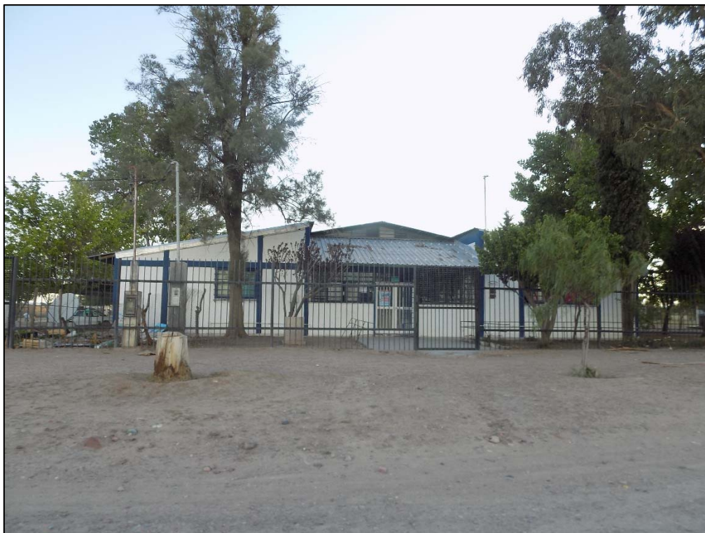
Fotografía N° 3 Infraestructura educativa en el área
