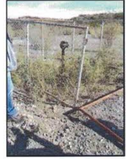
Foto N° 3 Vista al este de la locacion
