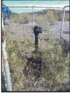
Foto N° 1 Vista a la boca de pozo con abandono definitivo
