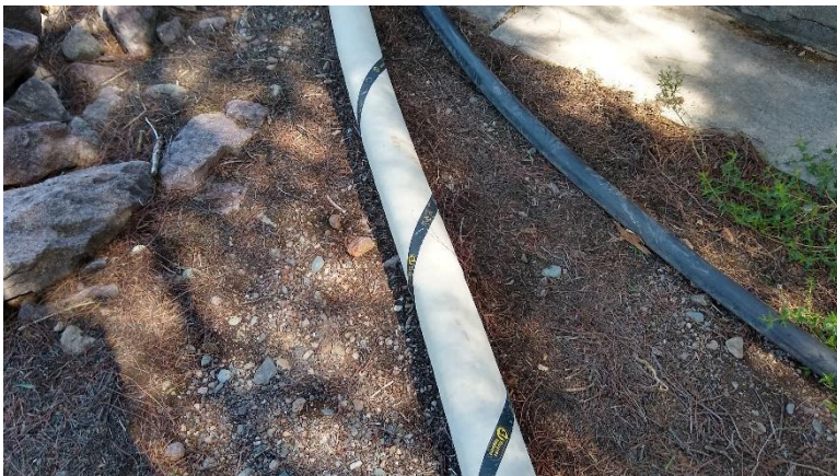
Fig. 13 – Cañería de conducción desde Planta de Neutralización hasta Dique DN 8-9.
