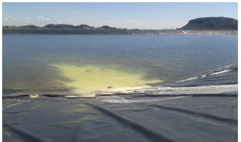
Fig. 14 – Descarga efluentes neutralizados a Dique DN 8-9.
