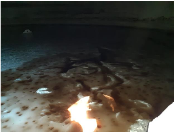
Fig. 15 y 16 – Depósito de sedimentos en el Tanque II luego del proceso de trasvase del Ácido Sulfúrico.
