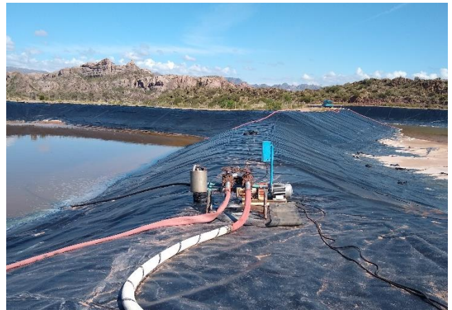
Fig. 7 y 8 – Instalación de bombeo desde el Dique DN 3B a la Planta de Neutralización.
