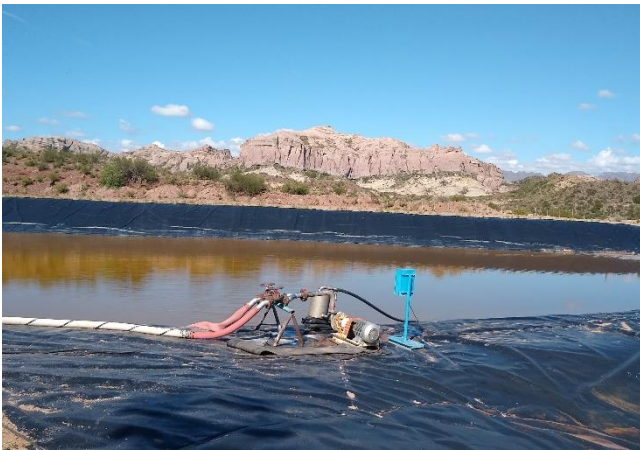
Fig. 7 y 8 – Instalación de bombeo desde el Dique DN 3B a la Planta de Neutralización.
