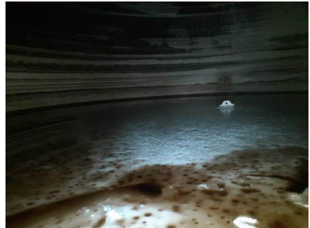
Fig. 15 y 16 – Depósito de sedimentos en el Tanque II luego del proceso de trasvase del Ácido Sulfúrico.
