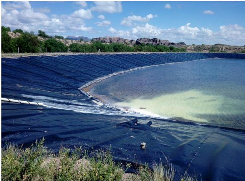
Foto N°3.- Ingreso del líquido neutralizado al dique de disposición final DN 8-9
