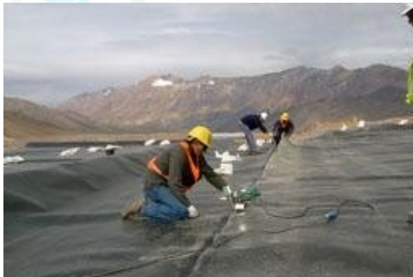
Figura 3. Soldadura mediante máquina con dispositivo de fusión mediante aire caliente
