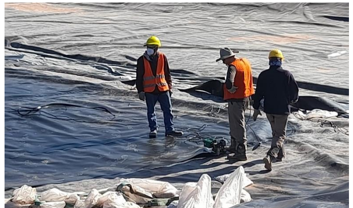
Fig.7.d – Soldadura de membrana inferior Dique DN5-Pulmón
