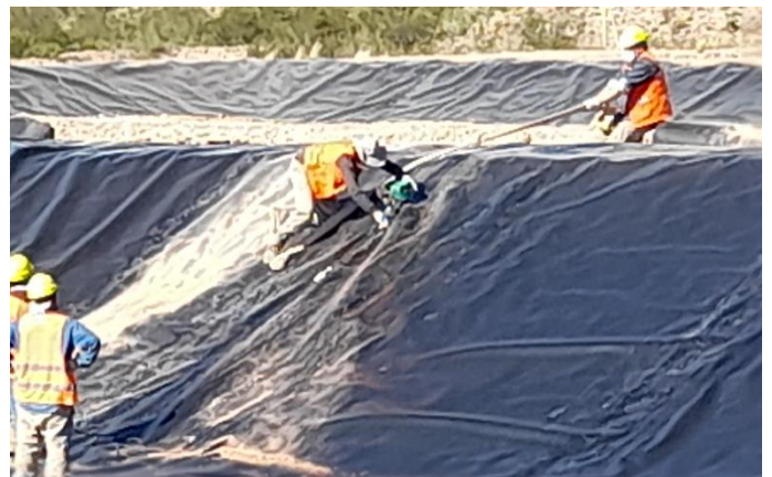
Fig.7.f – Detalle soldadura de membrana inferior en los taludes del Dique DN5-Pulmón
