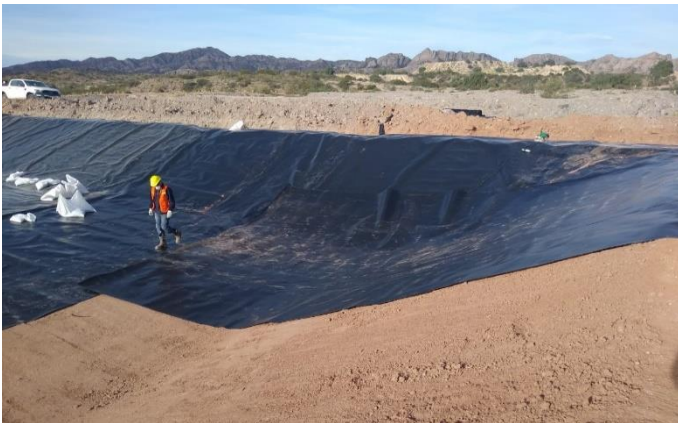
Fig.5.a – Colocación membrana inferior en fondo y taludes reservorio DN5-5.
