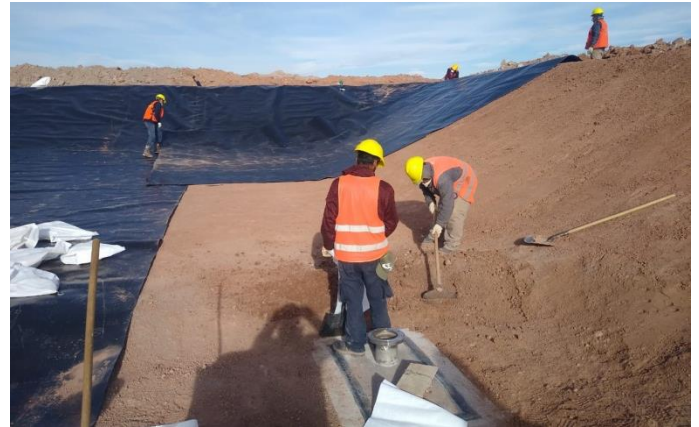
Fig.5.f – Ubicación del Sumidero de conexión al DN8-9 en el extremo del vaso del Dique DN5-5
