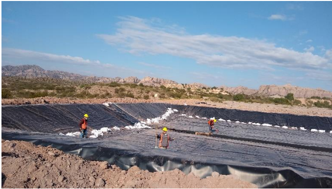
Fig.6.a – Cobertura finalizada Dique DN5-5. con Membrana Inferior.
