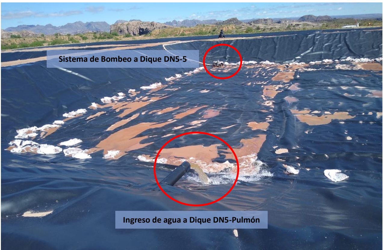
Fig.9.c – Detalle del ingreso del agua al Dique DN5-Pulmón y bomba sumergible que enviará el agua al Dique DN5-5.
