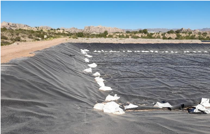
Fig.7.a – Impermeabilización finalizada vaso DN5-5.
