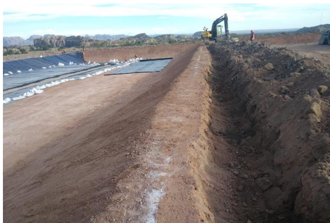
Fig.5.c – Excavación zanja lateral para anclaje de membranas.
