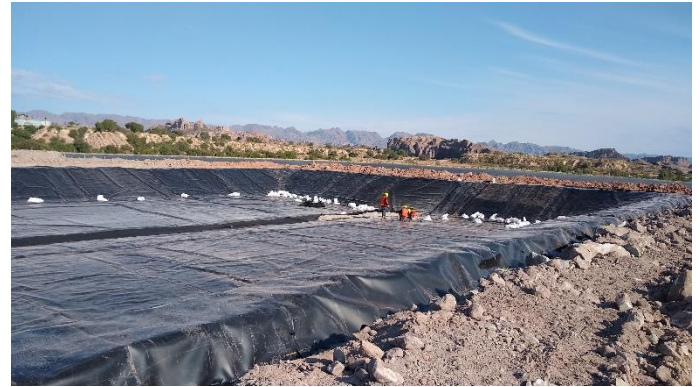
Fig.6.b – Cobertura finalizada Dique DN5-5. con Membrana Inferior.
