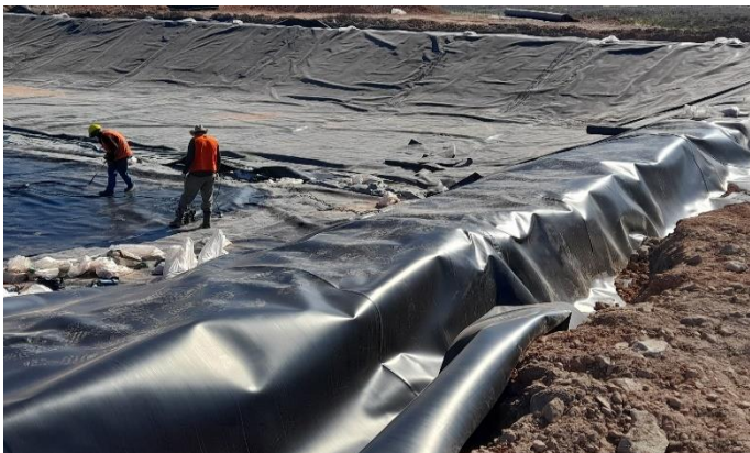
Fig.7.c – Soldadura de membrana inferior Dique DN5-Pulmón
