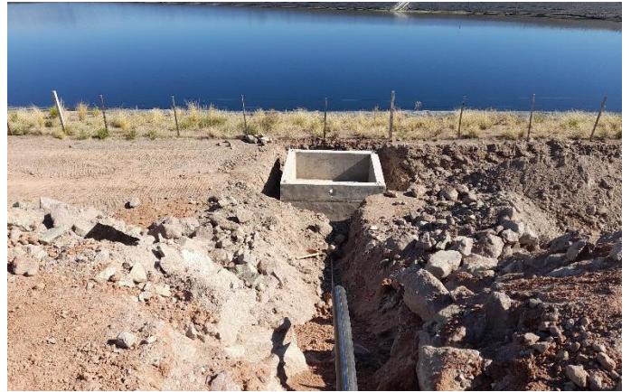
Fig.7.b – Zanjas para conexión a caseta de bomba.
