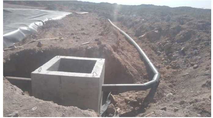
Fig.8.e – Instalación cañerías a las casetas de bombeo.
