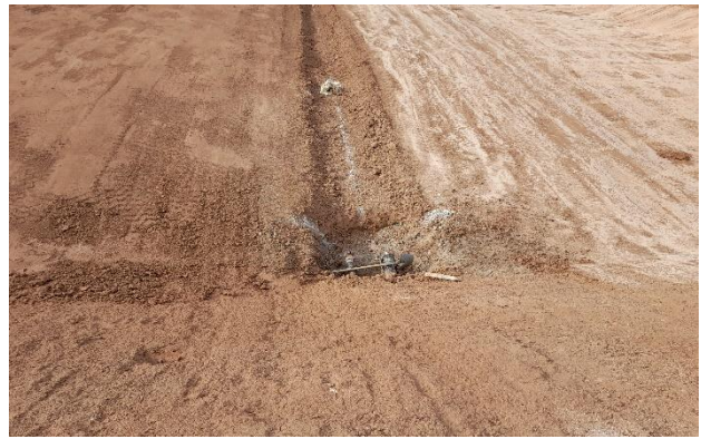
Fig.4.b – Conexión al Dique DN8-9 en el extremo de la zanja.
