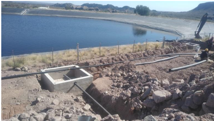
Fig.8.d – Instalación cañerías a las casetas de bombeo.
