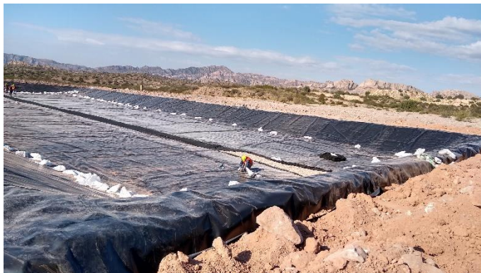
Fig.6.c – Anclaje Membrana Inferior del Dique DN5-
