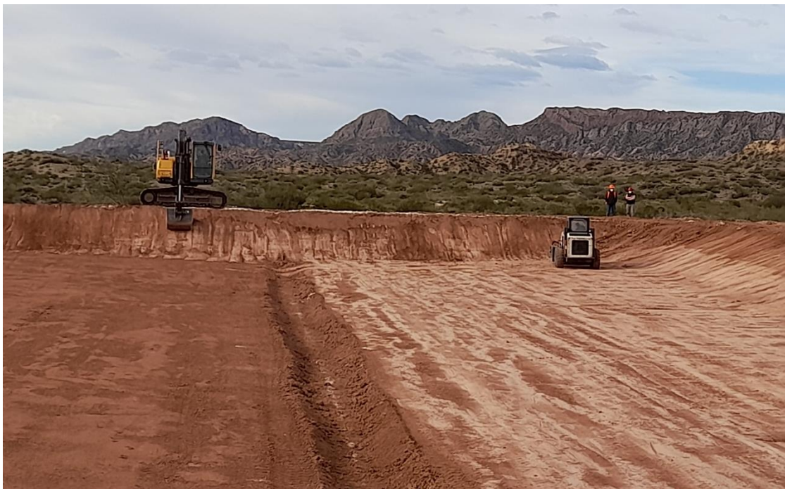
Fig.4.c – Trabajo de compactación de la arcilla sobre fondo y taludes del vaso DN5-5
