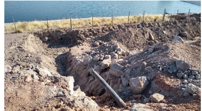
Fig.6.d – Zanja para conexiones de cañerías.
