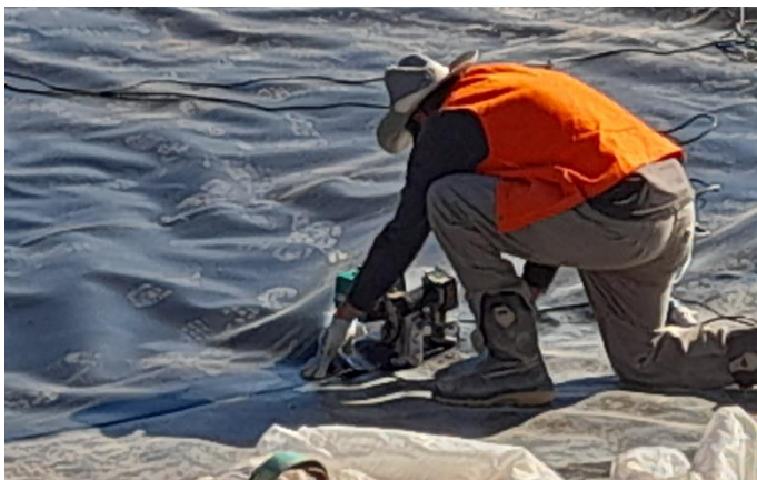
Fig.7.e – Detalle soldadura de membrana inferior en el fondo del Dique DN5-Pulmón
