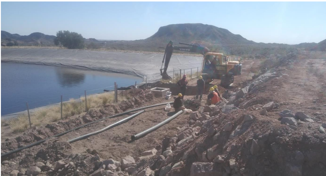
Fig.8.c – Personal trabajando en el sistema de conducción.
