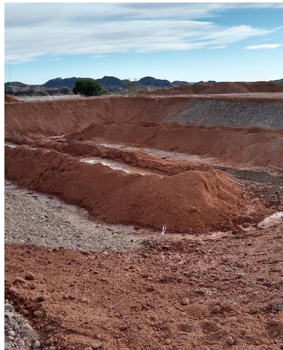
Fig.3. b – Acopio del material que conforma la base del vaso.
