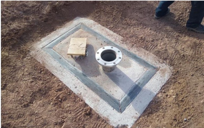
Fig.5.e – Sumidero de conexión al Dique DN8-9.
