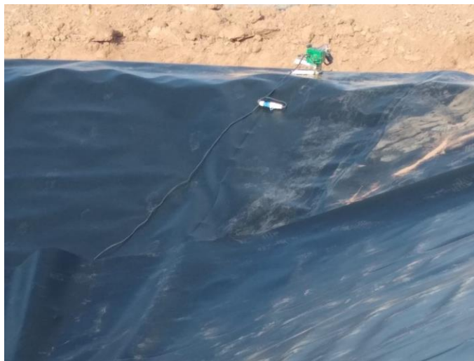
Fig.5.g – Soldadura de las bordes de las membranas.
