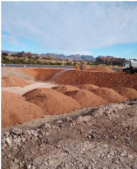
Fig.3. c – Acopio del material que conforma la base del vaso.
