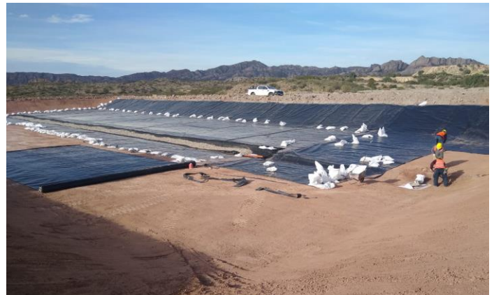
Fig.5.b – Colocación membrana inferior en fondo y taludes reservorio DN5-5.
