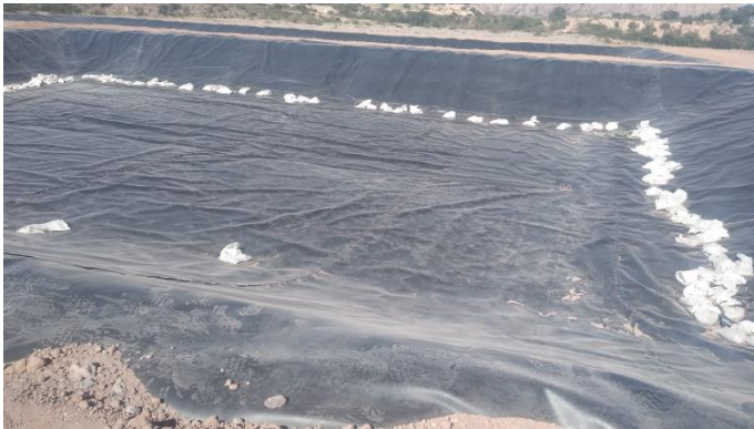
Fig.8.a – Instalación finalizada de la membrana inferior del Dique DN5-Pulmón
