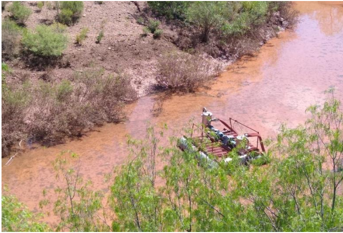
Fig.9.h – Bombeo desde Represa 2 a Cisterna 3
