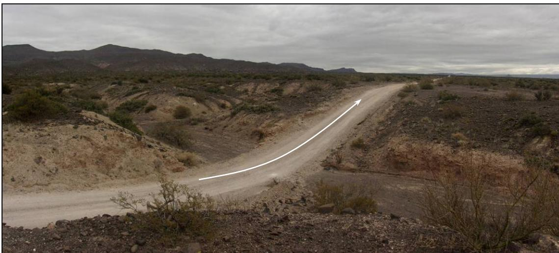
**Foto Nº 7:** Vista al Noroeste en la que se observa cauce de alta energía interceptar el camino de acceso a reacondicionar. Se puede denotar que el cruce con mismo se encuentra en óptimas condiciones.
