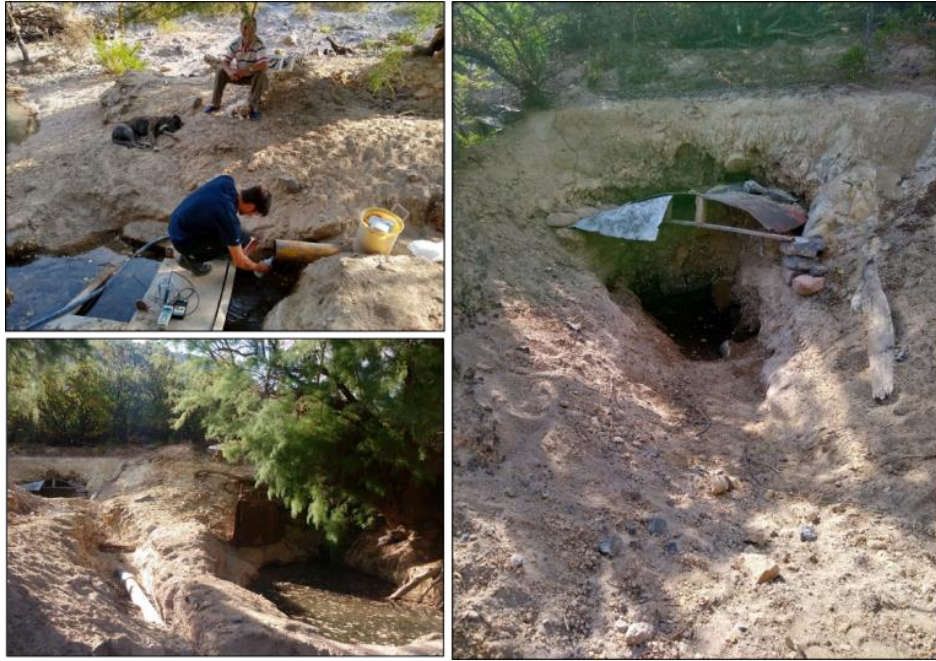
Fotografía 6 – Captación sitio PM1 “Puesto Jorge René Flores”.
