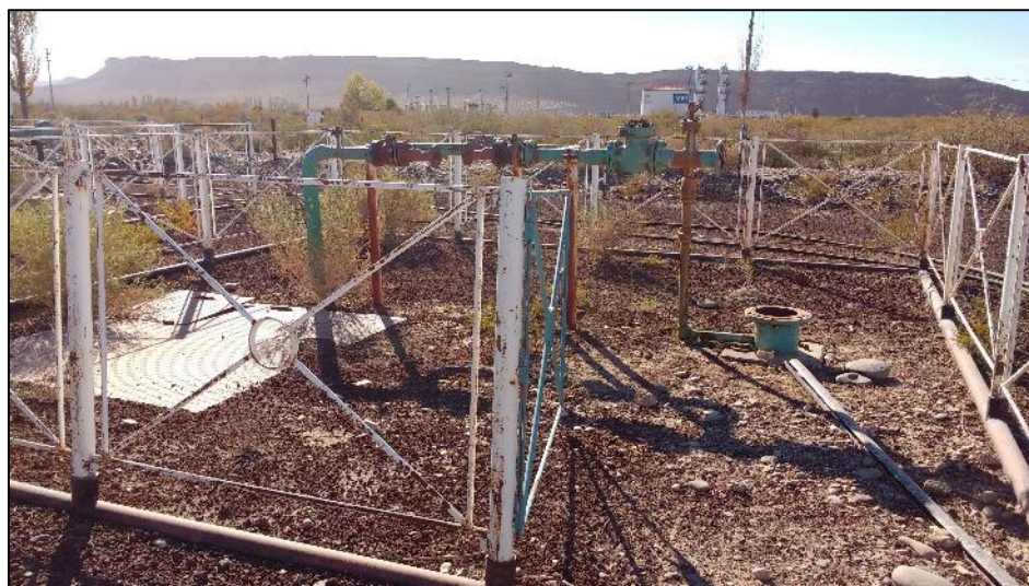
Fotografía 3 – Pozo de captación de agua (sitio PM15).
