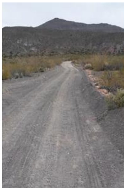
Vista al acceso a la futura locación
