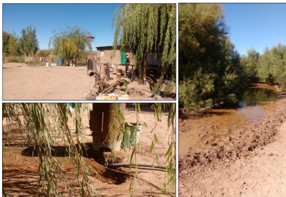
Fotografía 7 – Captación del manantial (Izquierda) y captación del río (derecha).
