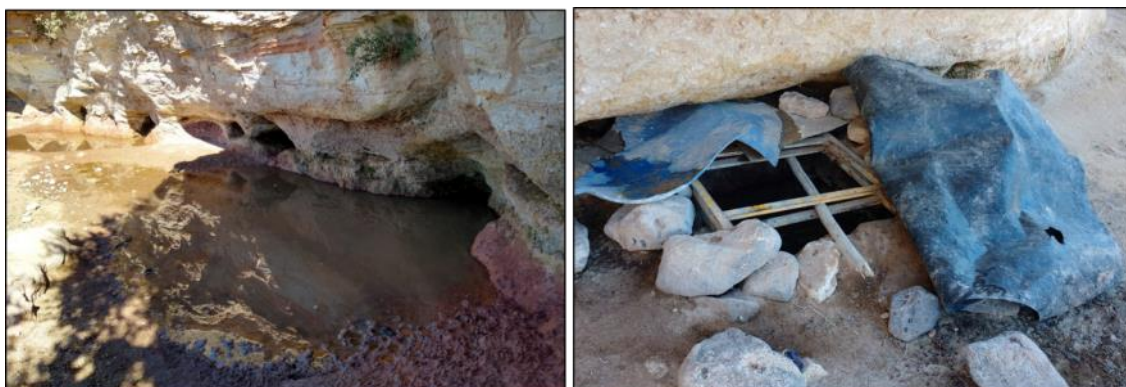
Fotografía 14 – Manantial sitio PM9 (izquierda) y sistema de captación (derecha).
