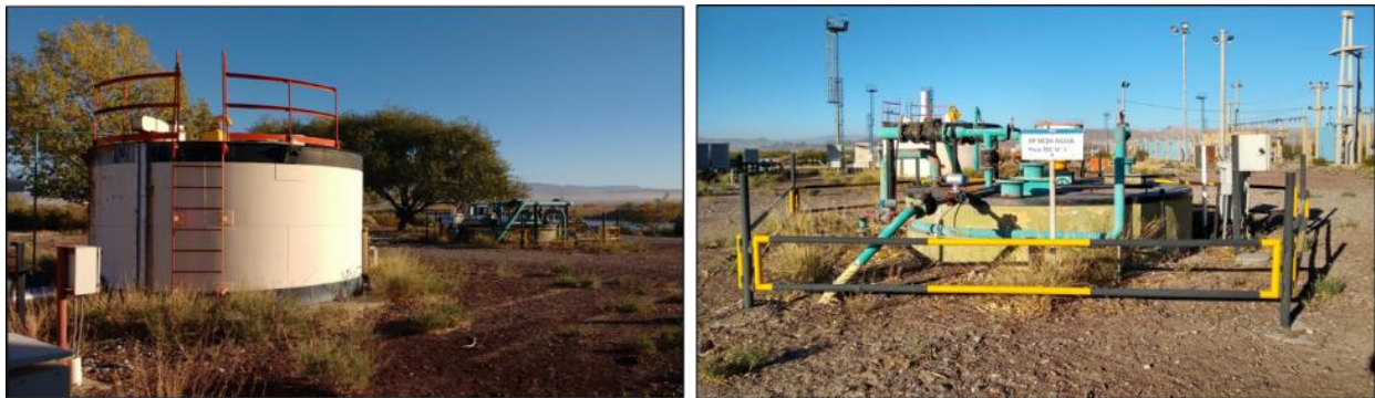
Fotografía 4 – Sistema de captación y almacenamiento de agua (sitio PM14).
