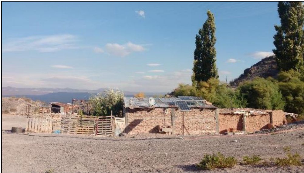
Fotografía 1 – Caserío ubicado en extremo sureste del bloque CN-VII/A (sitio PM1).
