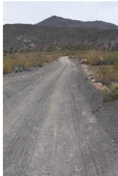
Foto N° 5 Vista al camino de acceso a la futura locación
