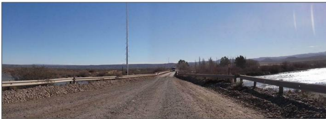
Foto Nº 3: Vista al Norte. Se observa el Puente de Pata Mora que une las provincias de Mendoza y del Neuquén.
