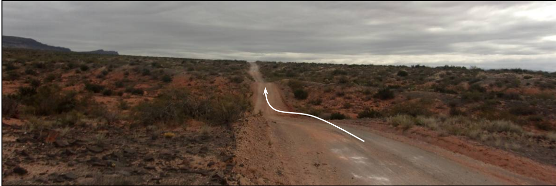
Foto N° 8: Vista al Norte. Se observa al camino a acondicionar interceptar un abanico de cauces de moderada a alta energía. Se denota que el cruce con los mismos se encuentran en buen estado de transitabilidad.
