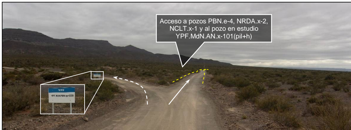
Foto N° 6: Vista al Norte. Se observa el inicio del camino a reacondicionar que lleva a los pozos existentes PBN.e-4, NRDA.x-2, NCLT.x-1 y al pozo en estudio YPF.MdN.AN.x-101(pil+h).
