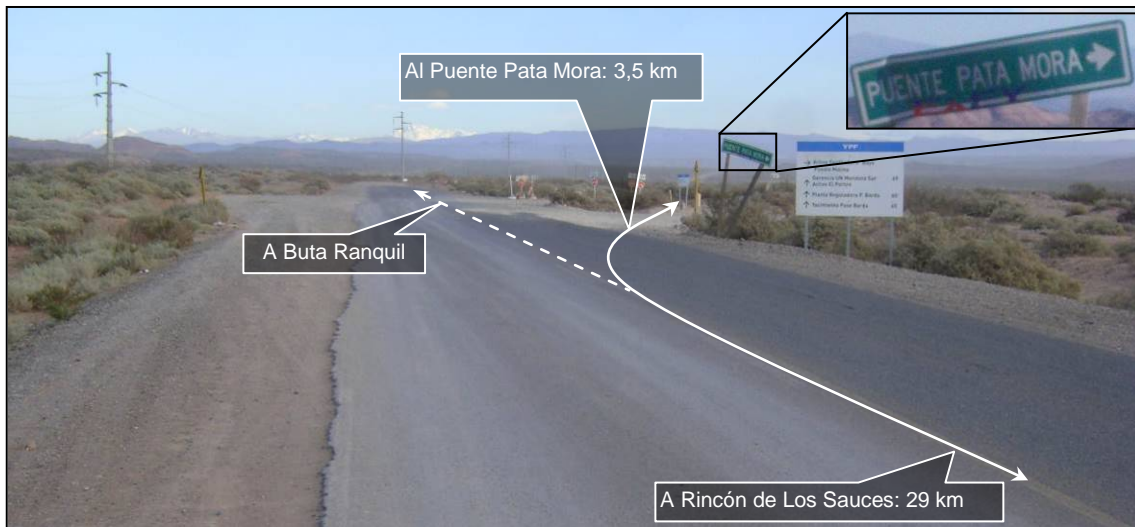
Foto Nº 2: Vista al Noroeste. Bifurcación entre la Ruta Provincial Nº 6 y el camino de acceso a Pata Mora y a los yacimientos Puesto Molina, Cañadón Amarillo y Paso Barda Norte, entre otros.
