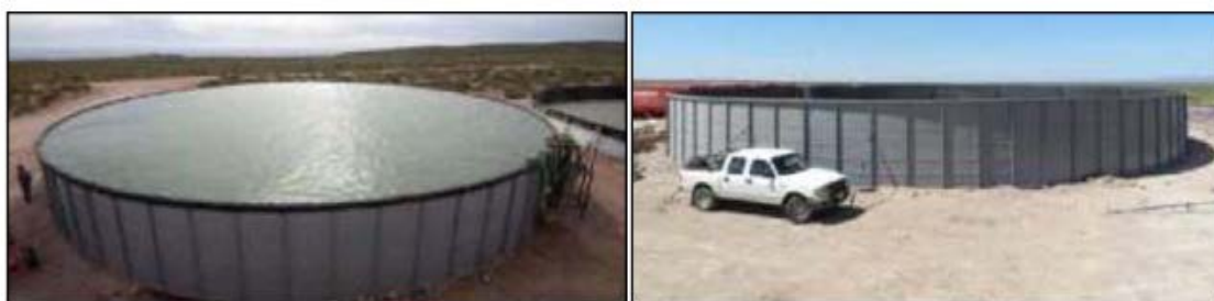
Fotos N° 10 y 11: Vistas de modelos de tanque australiano a instalar en la locación del pozo AN.x-101(pil+h).
