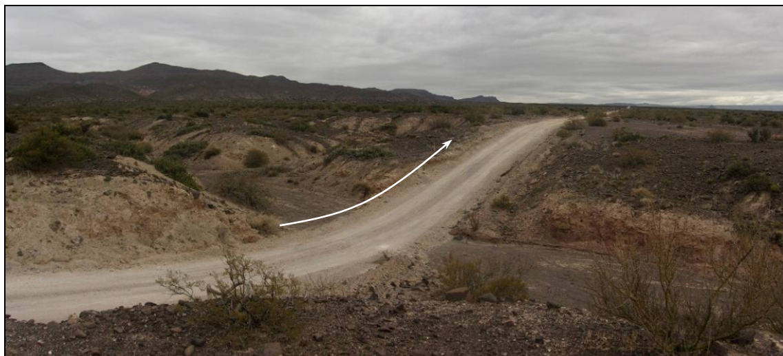
Foto N° 7: Vista al Noroeste. Se observa cauce de alta energía interceptar el camino de acceso a reacondicionar. Se puede denotar que el cruce con mismo se encuentra en óptimas condiciones.
