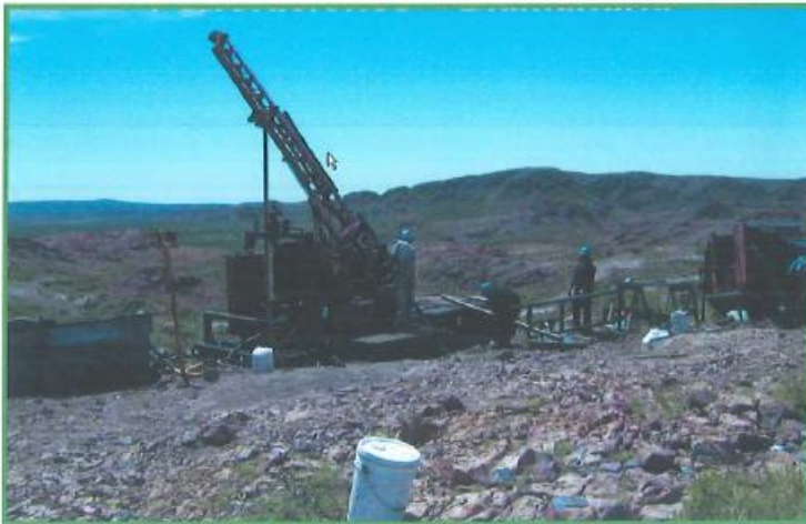
Equipo de perforación
