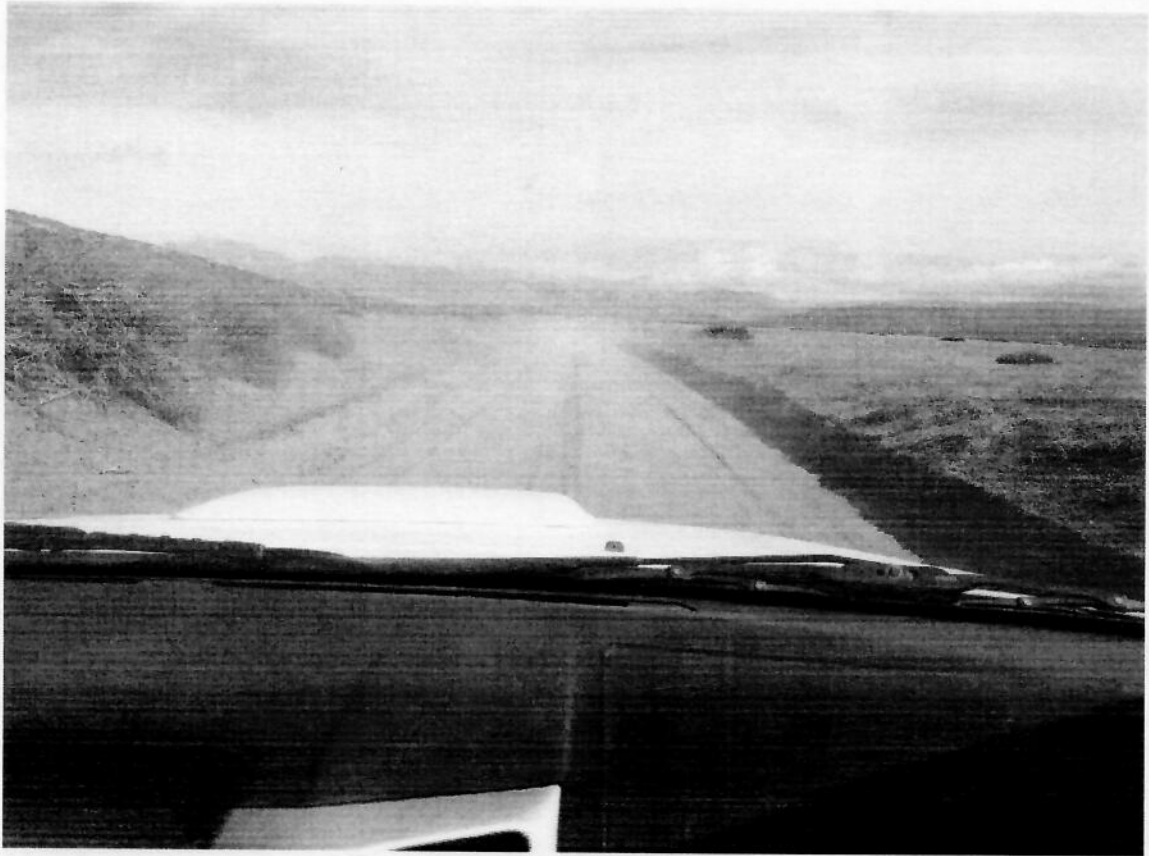
TRABAJOS EN CAMINO DE ACCESO AL AREA DEL PROYECTO H.I..
