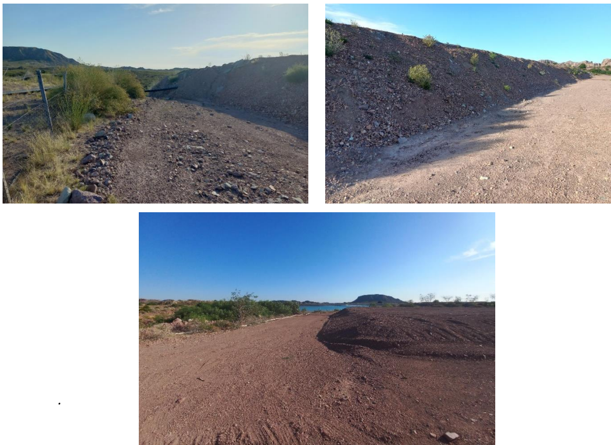
Fig.3 – Estabilización de taludes Dique DN5
