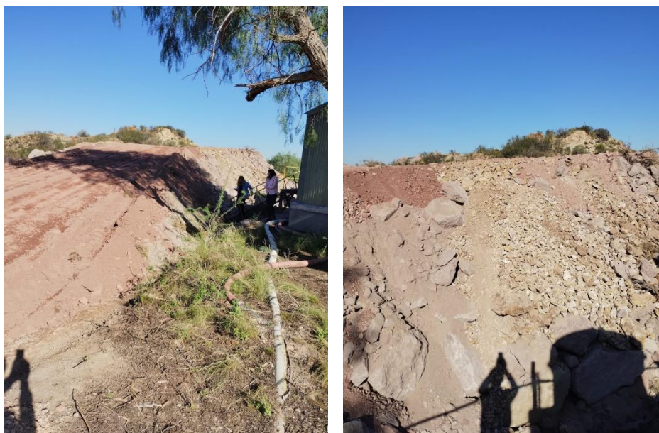
Fig.4 – Extracción de material y construcción de Terraplén de acceso.
