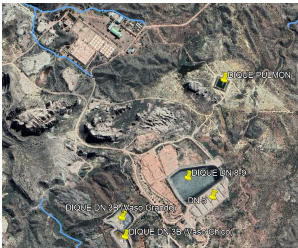
Fig. 14 – Ubicación Diques del CMFSR. Imagen Satelital Google Earth
