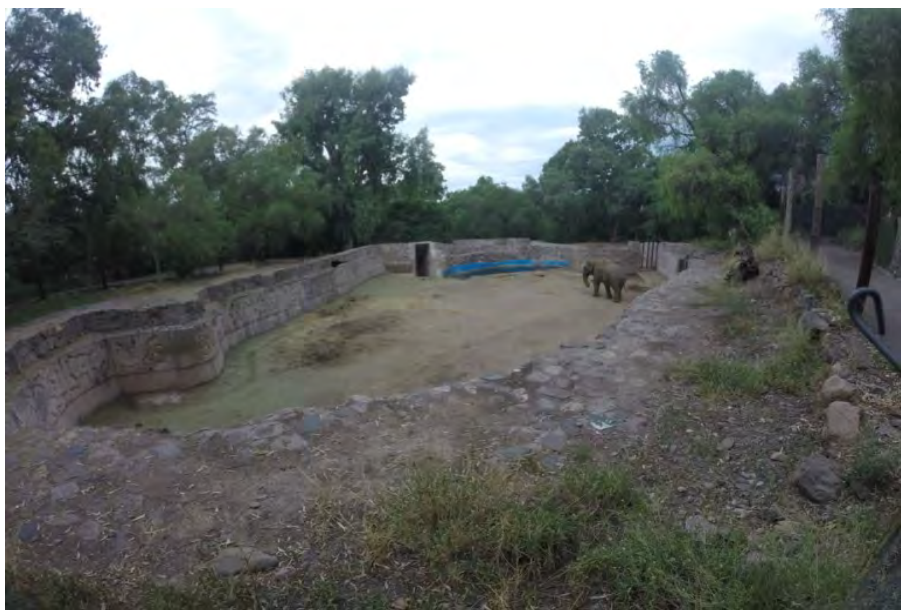
Foto 10: Ex recinto de elefantes que funcionará para retener excedentes pluviales
