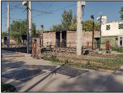
Estación existente calle Saenz Peña y Avellaneda
