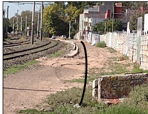
Zona apertura nuevo tramo calle Beltrán
