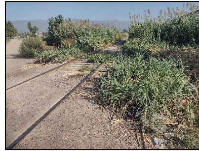
Cruce con vía de tren de carga
