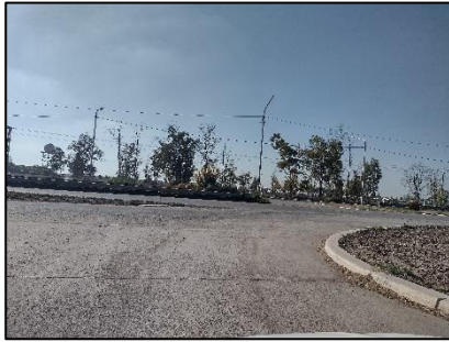
Vista al Este. Zona de Aeropuerto donde Llegará el MTM
