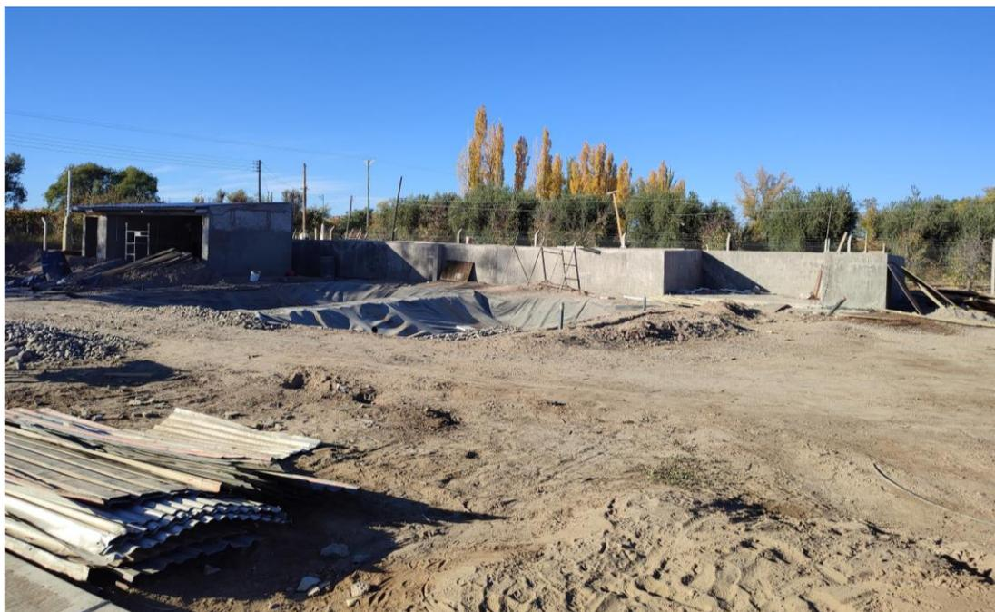
**Foto 2: Vista general de la PTE, piletas deshidratadoras de lodo y recinto para sopladores**
