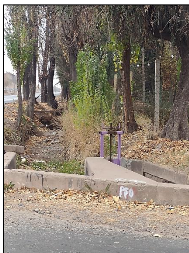
Foto N°6 Canal de riego sobre calle Maza
