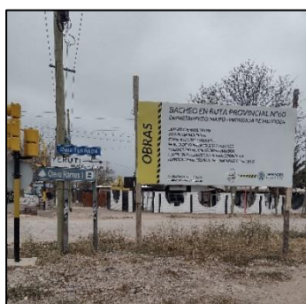
Foto N°12 Esquina al SE
