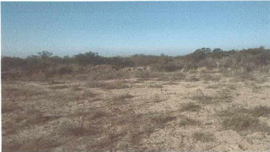
Foto N° 5: Desmonte realizado al final de camino de ingreso
