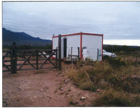
Fotografía N° 3 Se observa acceso al Proyecto, garita de control.
