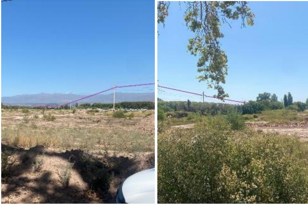
Foto 8 y 9 Tramo aéreo LAT 132 kV LAT ET Las Heras-ET Mendoza norte sobre LAT 66 kV existente. Vista desde Calle Paraná
