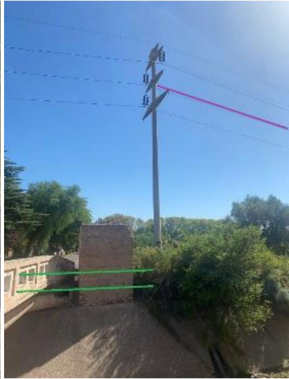
Foto 3 Tramo subterráneo paralela a LAT 132 KV existente, y transición subterráneo-aéreo
