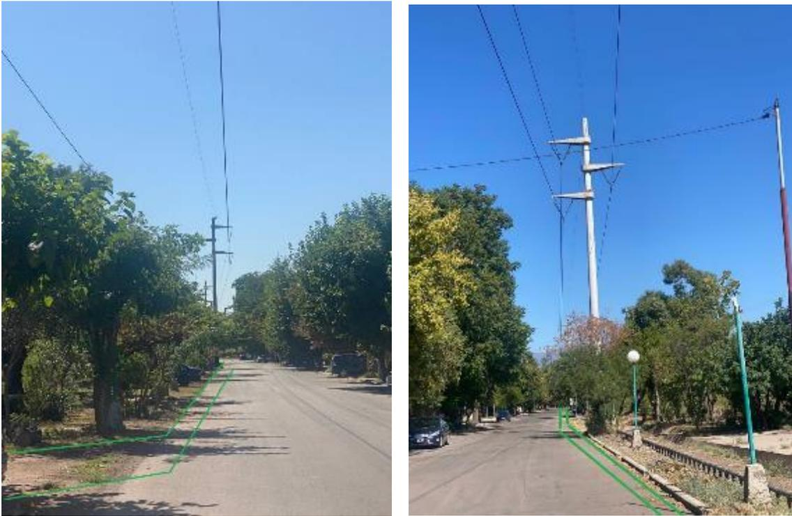
*Foto 5 y 6 Tramo subterráneo CAS 2x132 kV sobre servidumbre LAT 132 kV Las Heras-Rodeo de la Cruz*
