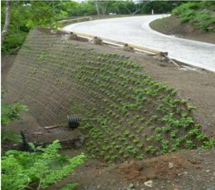
Figura 28: Sistema Terramesh. Está formado por una malla hexagonal de doble torsión asociados a una estructura de gaviones. Permite el desarrollo de la vegetación y está formado por materiales permeables. (Fuente: Muros de Suelo Reforzado con Sistema Terramesh. Date
