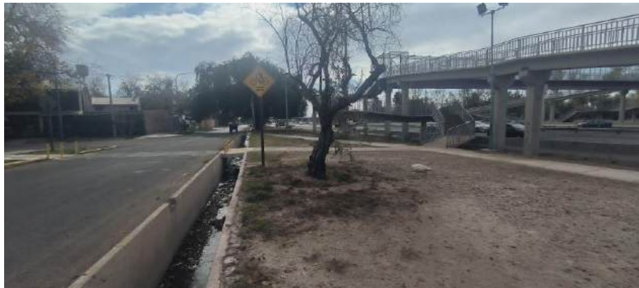
Imagen 13: Vista pasarela peatonal en intersección de Comechingones y RN 40.
