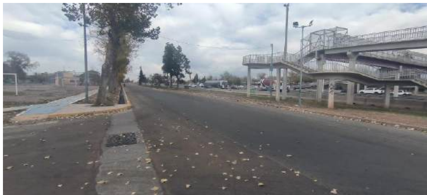
Imagen 15: Vista Lateral Este Acceso Sur.
