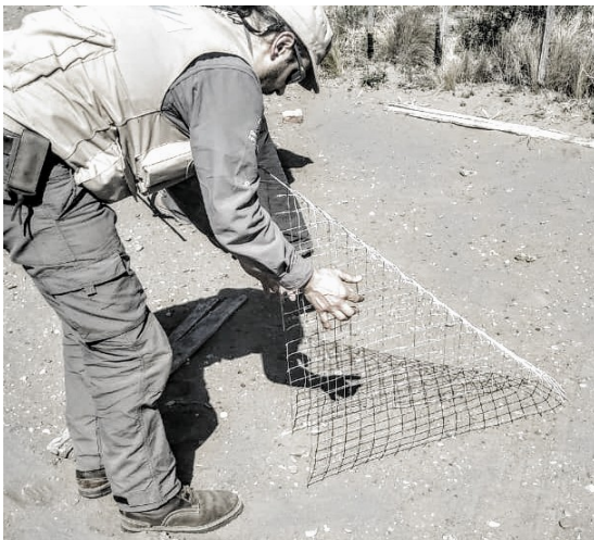
Figura n° 1: Plegado a mano de rampa de rescate o utilizando un molde rectangular de más de 1 mt. de largo x 0,10 mts. de ancho (madera)
