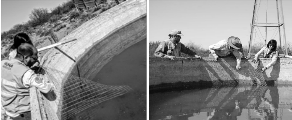
Figura n° 3 y 4: Colocación de rampa de rescate en tanque australiano, fijando la rampa al tanque, mediante alambre preferentemente.
